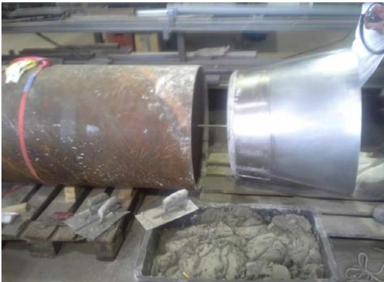
In figura 2.2.14, infine, è mostrato lo schema di intervento per procedere ad un rinforzo della condotta mediante posa di rete elettrosaldata prima della
