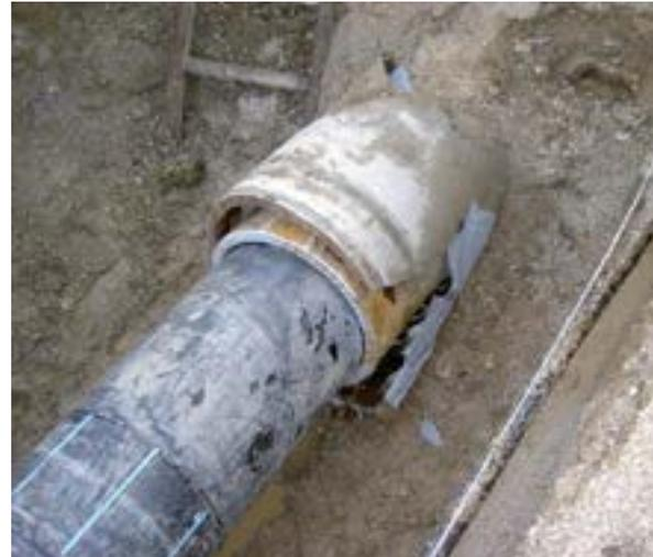
Nella figura 2.5.1 è raffigurata un'ogiva che sta entrando nel vecchio condotto del quale è prevista la sostituzione. Le lame di taglio possono essere fisse (come utilizzato frequentemente nel caso di materiale duttile: acciaio, materie plastiche, ghisa sferoidale) o mobili (per materiali fragili: per ghisa grigia, cemento, gres). L'ogiva viene trainata da un argano posto nella
